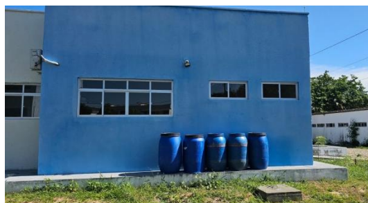
Bombonas destinadas ao armazenamento externo dos coletores de resíduos infectantes e perfurocortantes, com acesso facilitado para a coleta externa.
